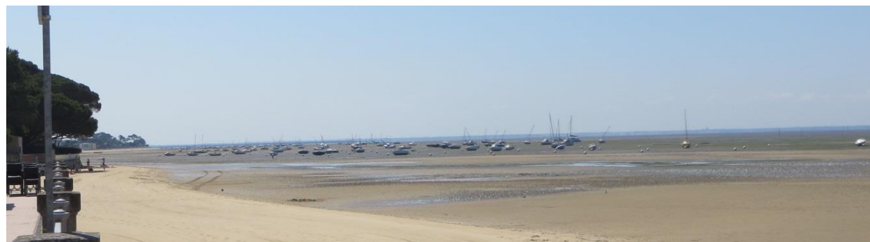
Façade littorale maritime à marée basse
