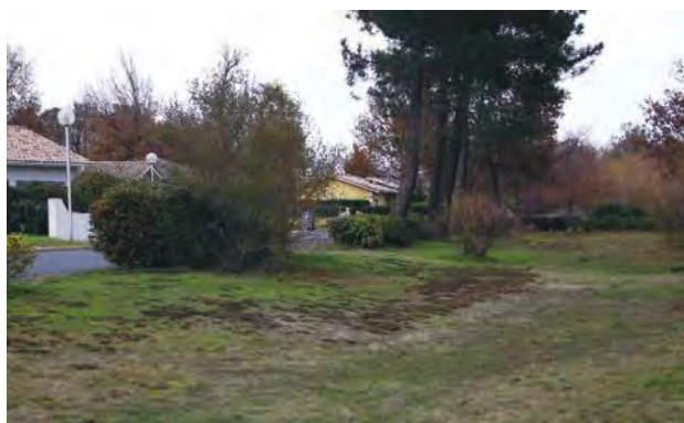
Noue en site « sable des Landes » avec présence de la nappe phréatique à faible profondeur.
